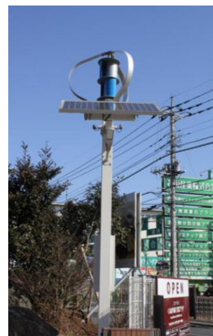
▲風力+太陽光の一体型発電装置
